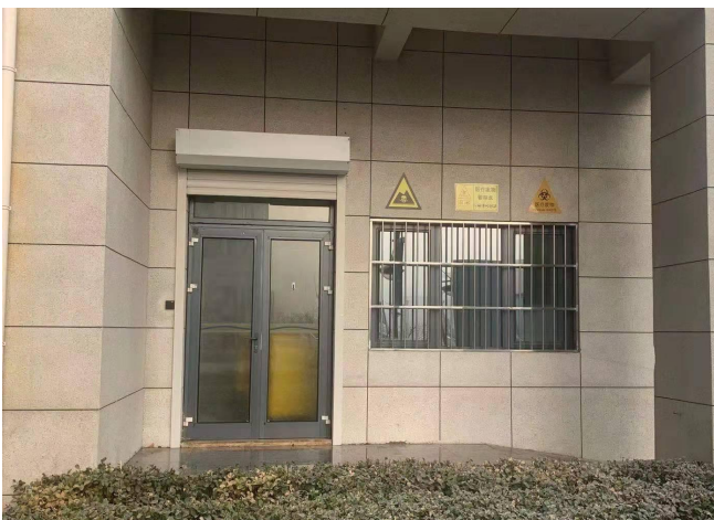
医疗废物暂存间
