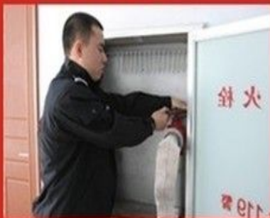
5、打开消火栓上的水阀开关
