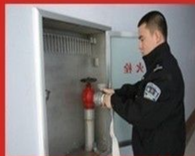
3、水带一头接在消火栓接口上
